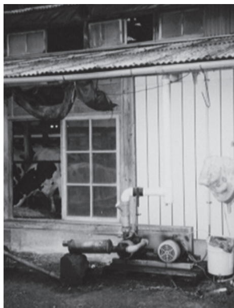
図20 ポンプの観察ポイント (設置環境) 雨ざらしの環境である
