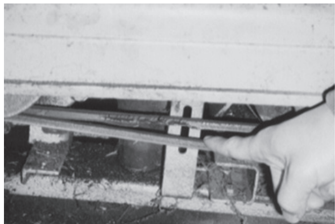
図17 ポンプの観察ポイント(Vベルト) 亀裂が生じているVベルト 放置しているとある日突然動かなくなる
