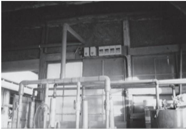
図22 ポンプの観察ポイント（設置事例） 4台のポンプを綺麗に配管しているが、問題が多い配管である
