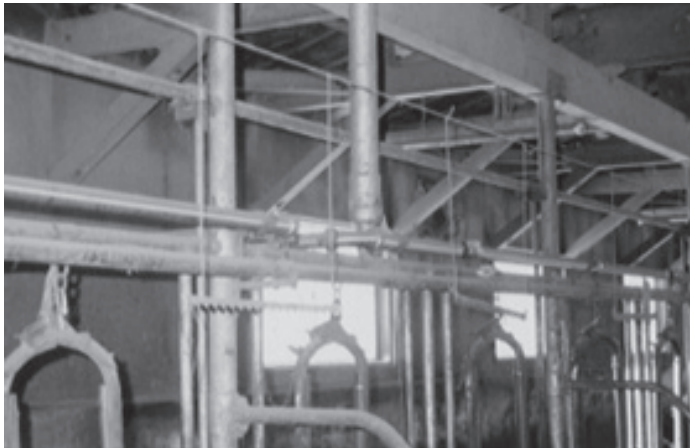
図32 2ライン方式配管 パルセーターラインの分岐部を示す
