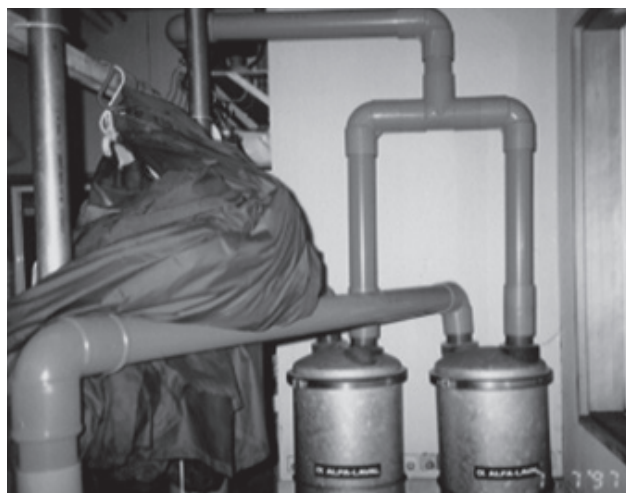
図13 ポンプの観察ポイント(配管) 2台のポンプの接続方式が問題となる事例 タンクに直接つなく配管にする
