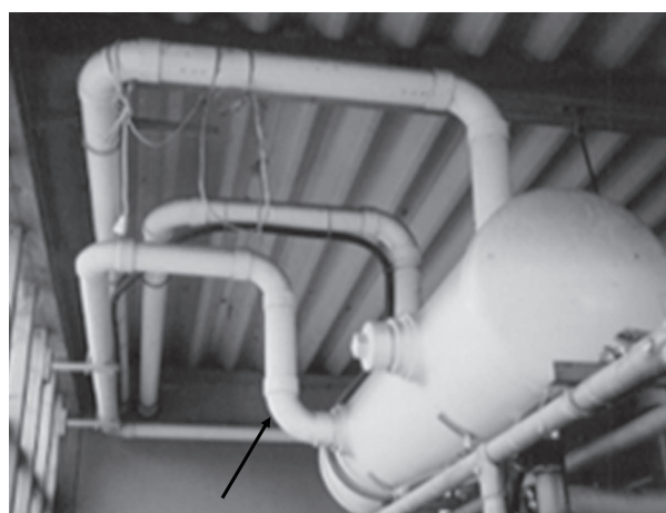
図25 バランスタンク（設置場所） パーラーの天井に設置されているタンク 矢印はロングエルボー配管
