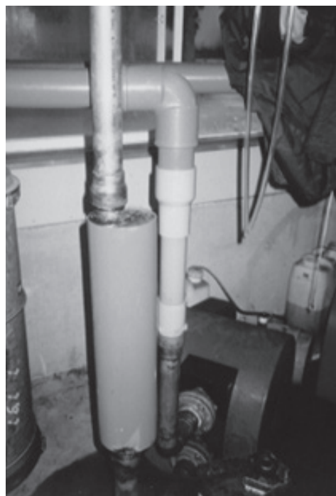
図12 ポンプの観察ポイント(配管) ポンプへの直接配管事例
