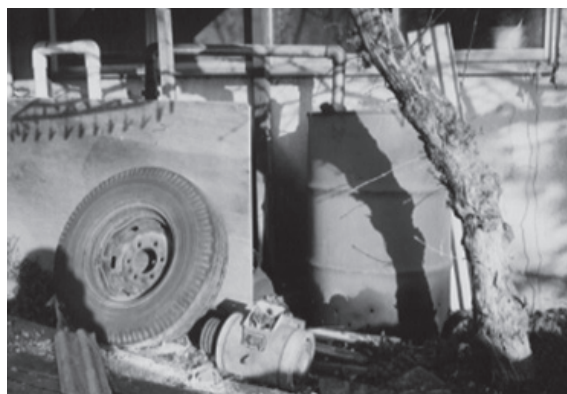
図9 ポンプの観察ポイント(マフラー) ドラム缶による排気の制約事例 雪国では落雪による排気制約も考慮する
