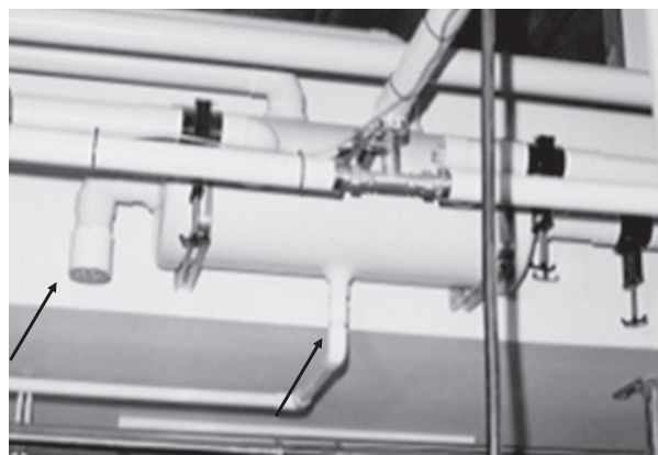
図36 タンクの配管仕様 タンクへの配管の仕方 矢印はドレイン配管とポップオフバルブ
