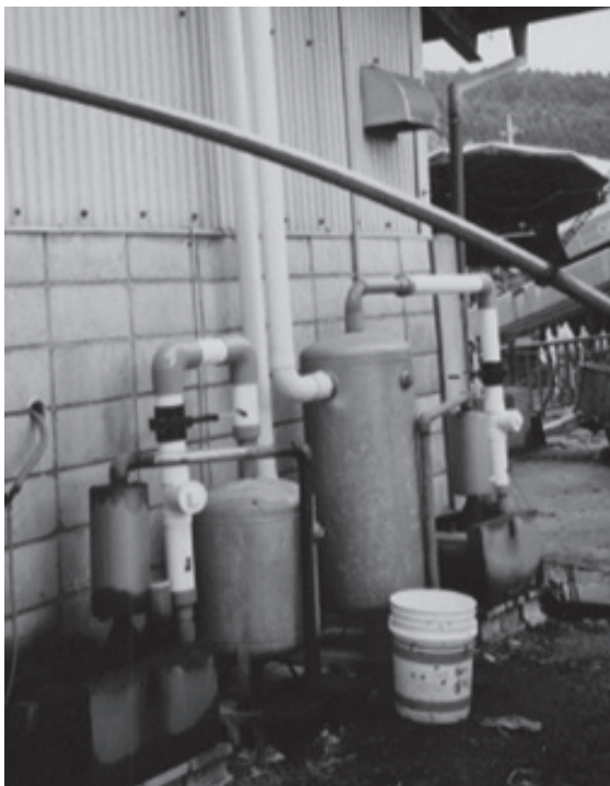
図33 ポンプ近くのタンク 真空2系統方式のために、この位置に設置されている。
