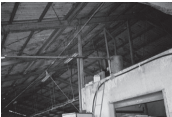
図5 ポンプの観察ポイント(マフラー) 建物の上にあるポンプから牛舎を横断して マフラーが伸びている
