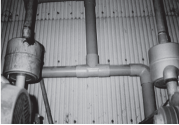
図10 ポンプの観察ポイント（逆止弁）
