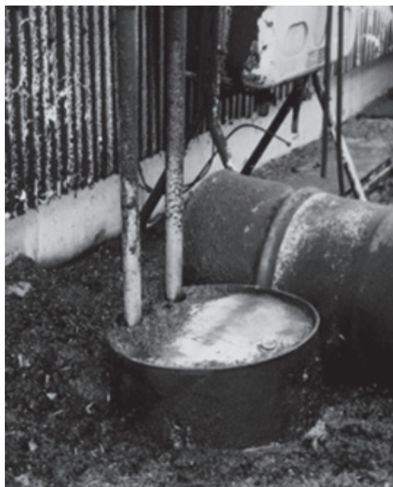
図7 ポンプの観察ポイント(マフラー) ドラム缶による排気の制約事例
