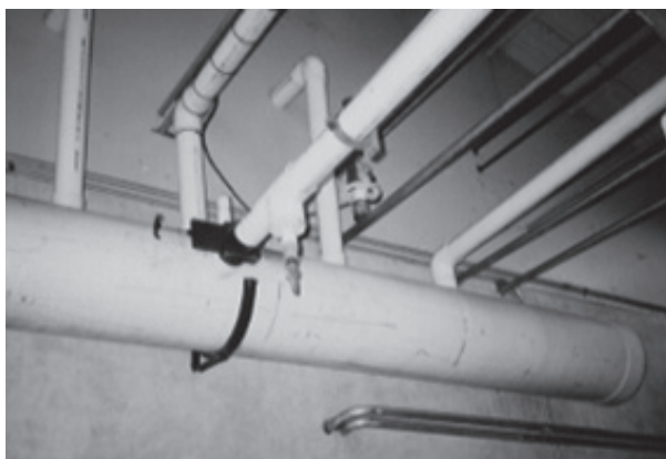
図29 バランスタンク 2台のタンクを接続して配管容積を増やしている
