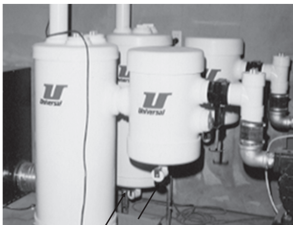
図24 バランスタンク（設置場所） 独立して設置されているバランスタンク 矢印は排水用ドレインを示す
