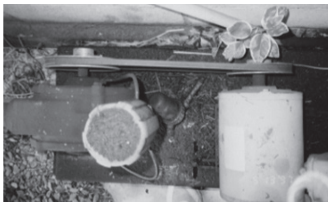
図18 ポンプの観察ポイント (Vベルト) モーターとポンプの間にねじれが生じている
