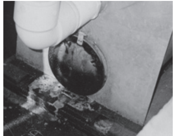
図28 バンランスタック 牛乳が流れ出た跡があるポンプ下に設置 されているタンク
