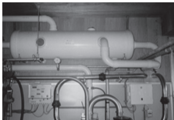
図30 3ライン方式配管 タンクから出る配管本数により決まる
