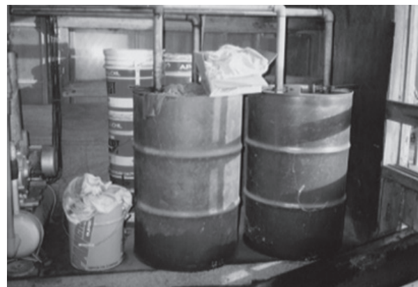
図6 ポンプの観察ポイント(マフラー) ドラム缶による排気の制約事例 4本のマフラーがドラム缶に入っている
