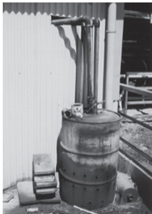
図8 ポンプの観察ポイント(マフラー) ドラム缶による排気の制約事例
