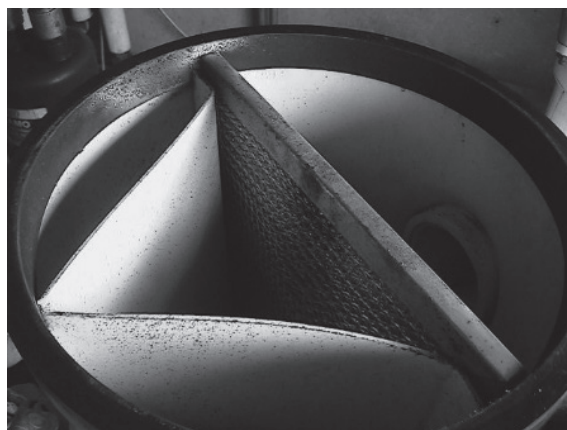
図26 ポンプ前のプレタンク ゴミの侵入を防ぐフィルターがある
