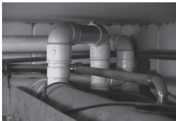
図35 配管の曲がり（エルボー） 直角エルボー仕様の配管
