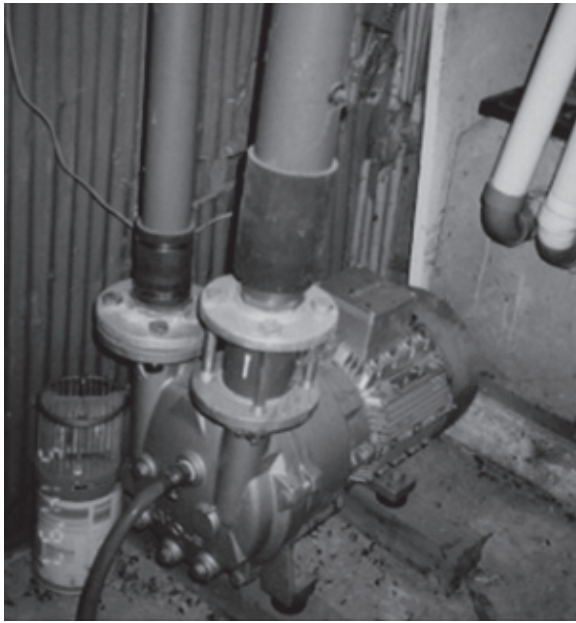
図4 バキュームポンプの種類 ウオーターシールタイプのポンプ 近くに水槽(タンク)が必ずある
