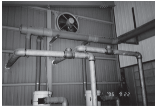
図23 ポンプの観察ポイント（設置事例） 配管を太くすることで、タンクの代わりや、配管接続の問題をなくした例
