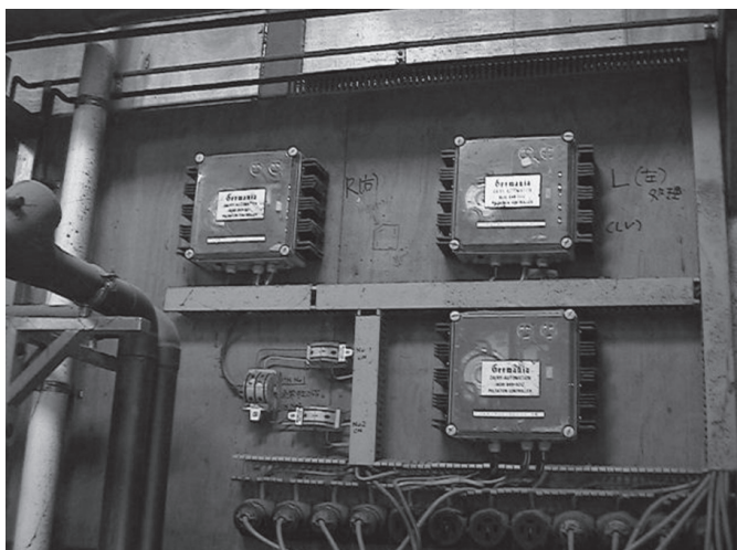
図1 電気式パルセーターの電源ボックス ここから信号をパルセーターに送り、拍動回数や比率を決めている。
