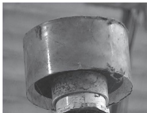
図7 パルセーターに空気を供給する配管に取り付けられているエアフィルター
